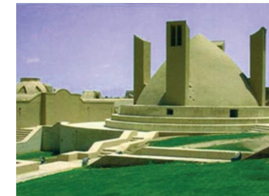
Şekil 5: Rüzgâr kapanları ile havalandırılan ve soğutulan sarnıç
