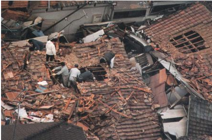
Şekil 3.2 Yangın sonrası hasar ve gönüllü çalışmaları
