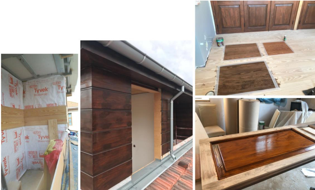
Şekil 1.13 Merdiven, döşeme ve duvarlarda ahşap kaplamaların uygulanması
