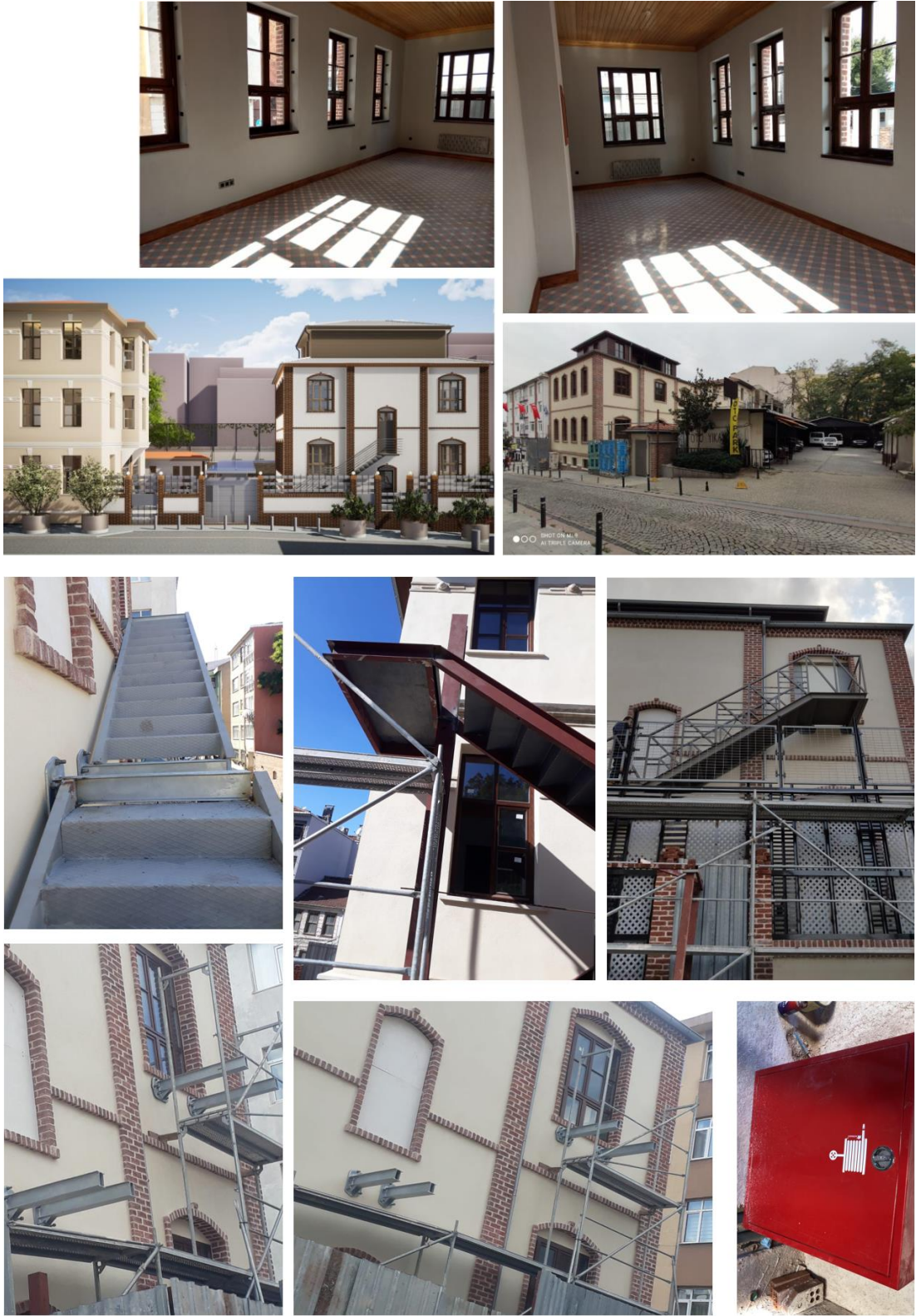
Şekil 1.14 Cephelerin restorasyonu, kaçış merdiveninin yerleştirilmesi
