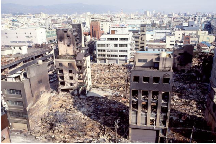
Şekil 3.1 Yangın sonrası hasar
