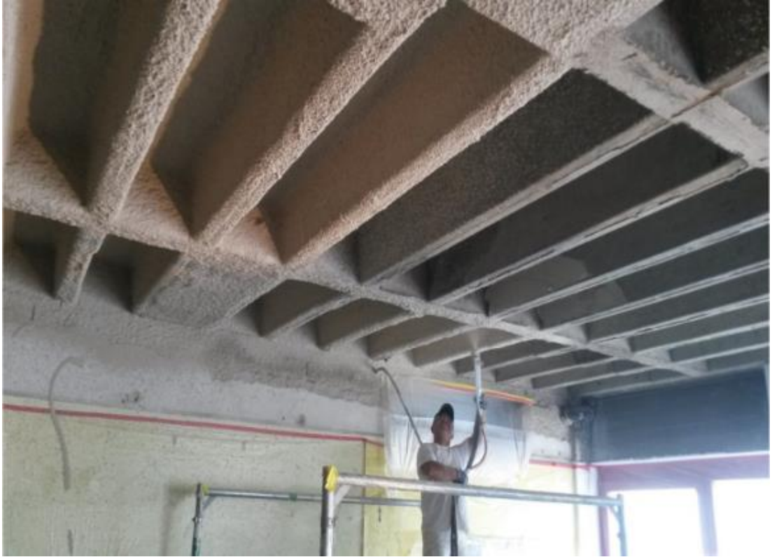
Şekil 5.3 Yangına dayanıklı alçı sıva uygulama örneği
