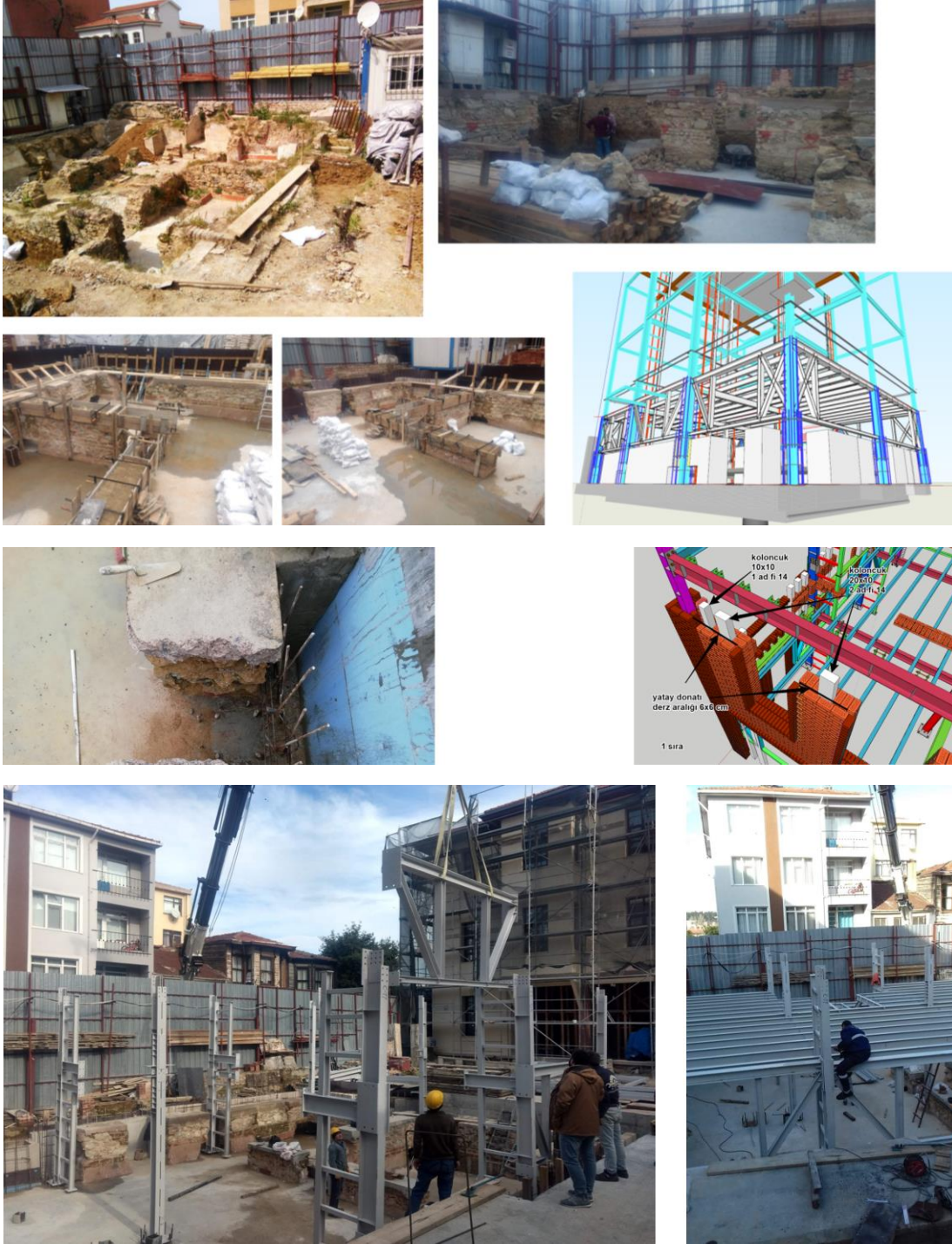
Şekil 1.2 Okulun şantiye alanından görüntüler, strüktürel çelik taşıyıcı sistem kurulumu
