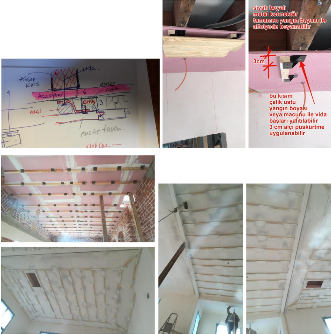
Şekil 1.9 Alçı panellerin uygulandığı tavanın görünümü
