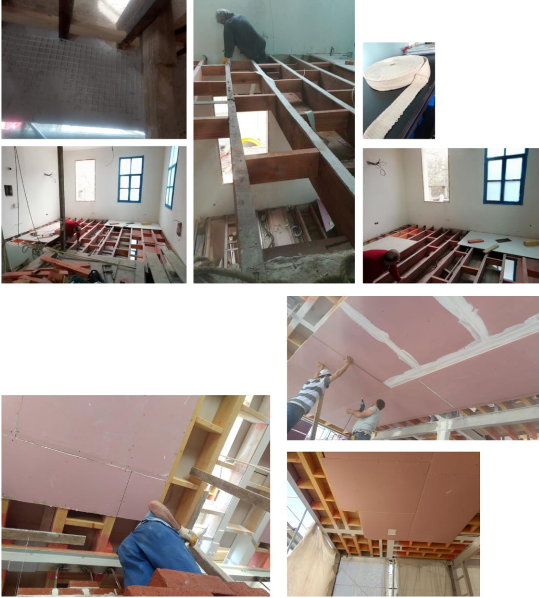
Şekil 1.8 Tavanın alçı paneller ile kaplanması
