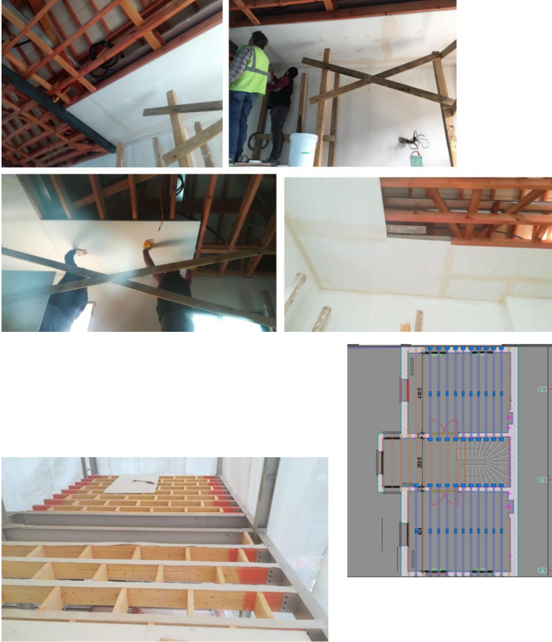
Şekil 1.6 Ahşap döşeme taşıyıcı sistemin uygulanması
