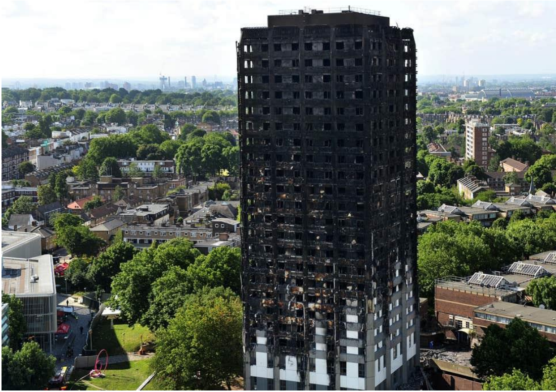
Şekil 2.5 Grenfell Tower, Londra
