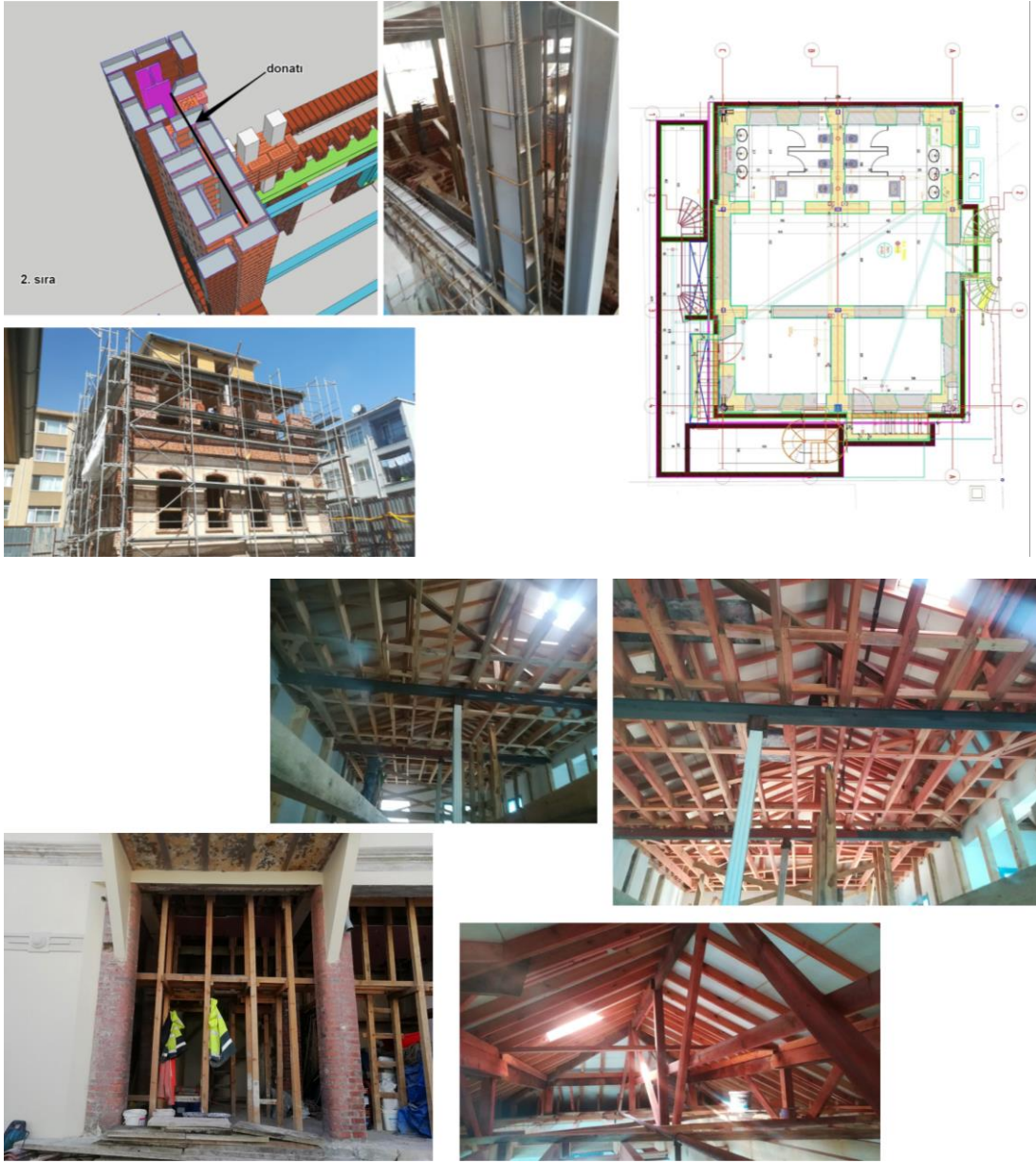
Şekil 1.5 Çatı ve cephe restorasyonu
