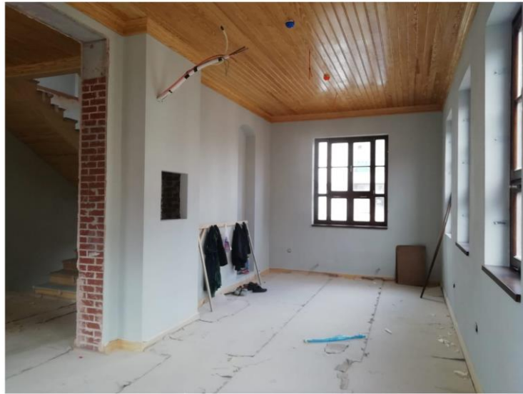
Şekil 1.10 Ahşap tavan kaplaması bulunan tavanlara intümesan şeffaf vernik uygulaması
