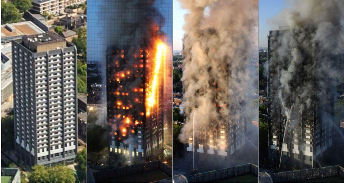
Şekil 2.2 Grenfell Tower, Londra
