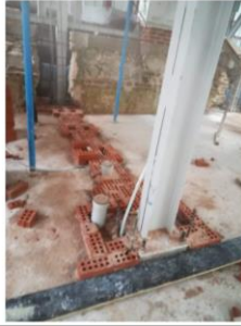
Şekil 1.4 Volta döşeme uygulaması, çelik döşeme kirişlerinin yerleşimi
