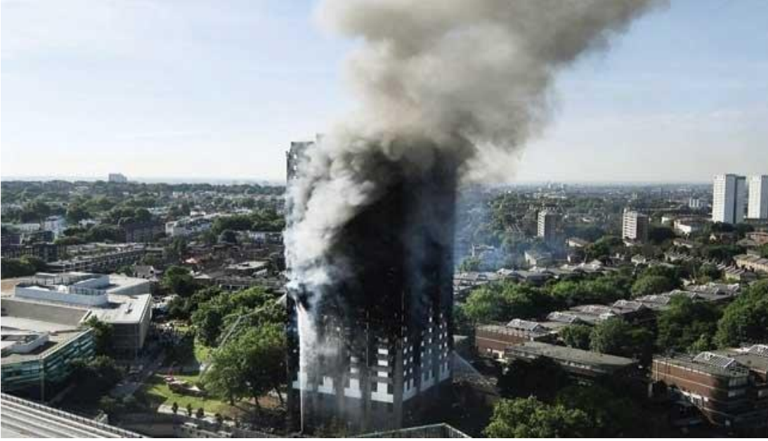
Şekil 2.4 Grenfell Tower, Londra
