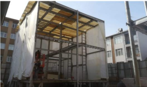
Şekil 1.4 Volta döşeme uygulaması, çelik döşeme kirişlerinin yerleşimi
