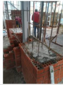
Şekil 1.4 Volta döşeme uygulaması, çelik döşeme kirişlerinin yerleşimi
